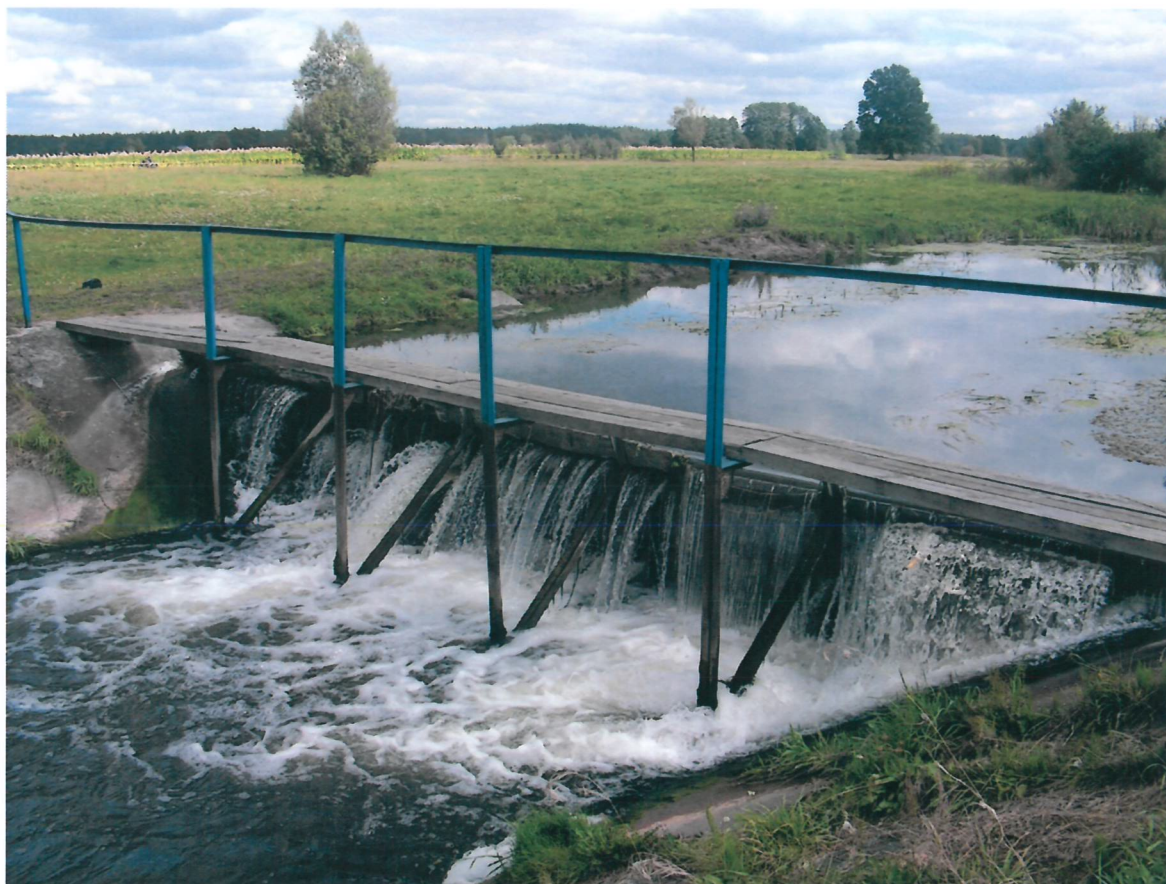
Zdj. 5. Jaz piętrzący kozłowy Chodlik w km 11+650 rzeki Chodelki.
